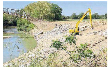
Alcuni dei lavori in corso per mettere in sicurezza il Ponte francese in località Grancia
